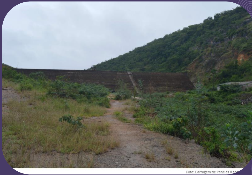
Foto: Barragem de Panelas II abn
