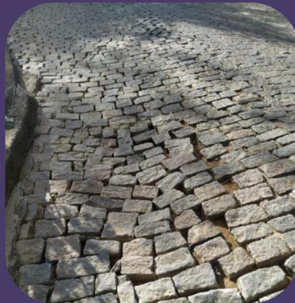
Ex.: Reconstrução de Pavimento
