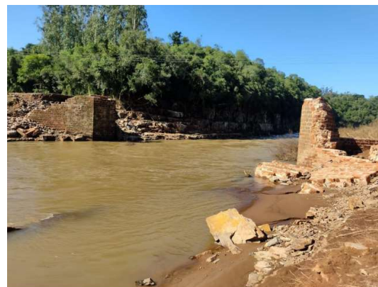
Ponte em Arroio do Tigre/RS
