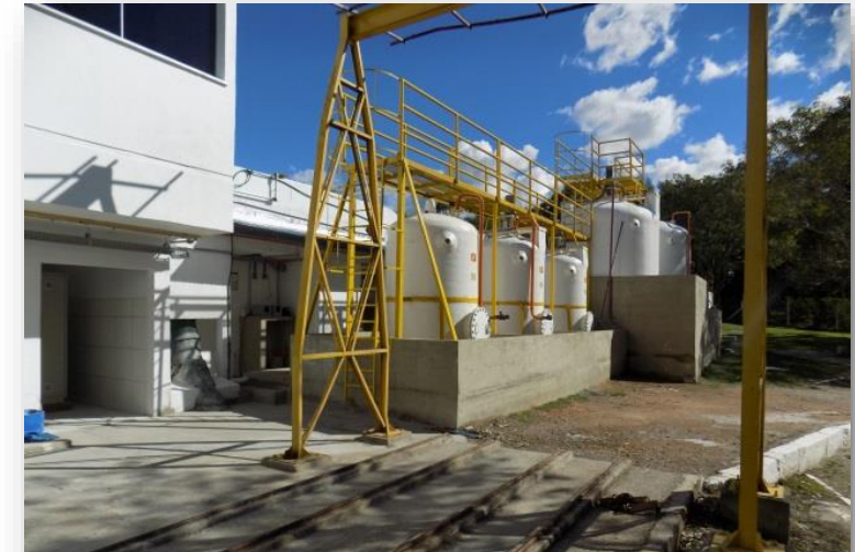
Tanque de armazenamento de químicos -ETA
