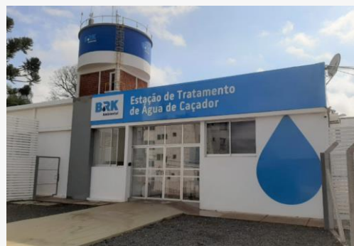
CAÇADOR, SC (Água e Esgoto)
